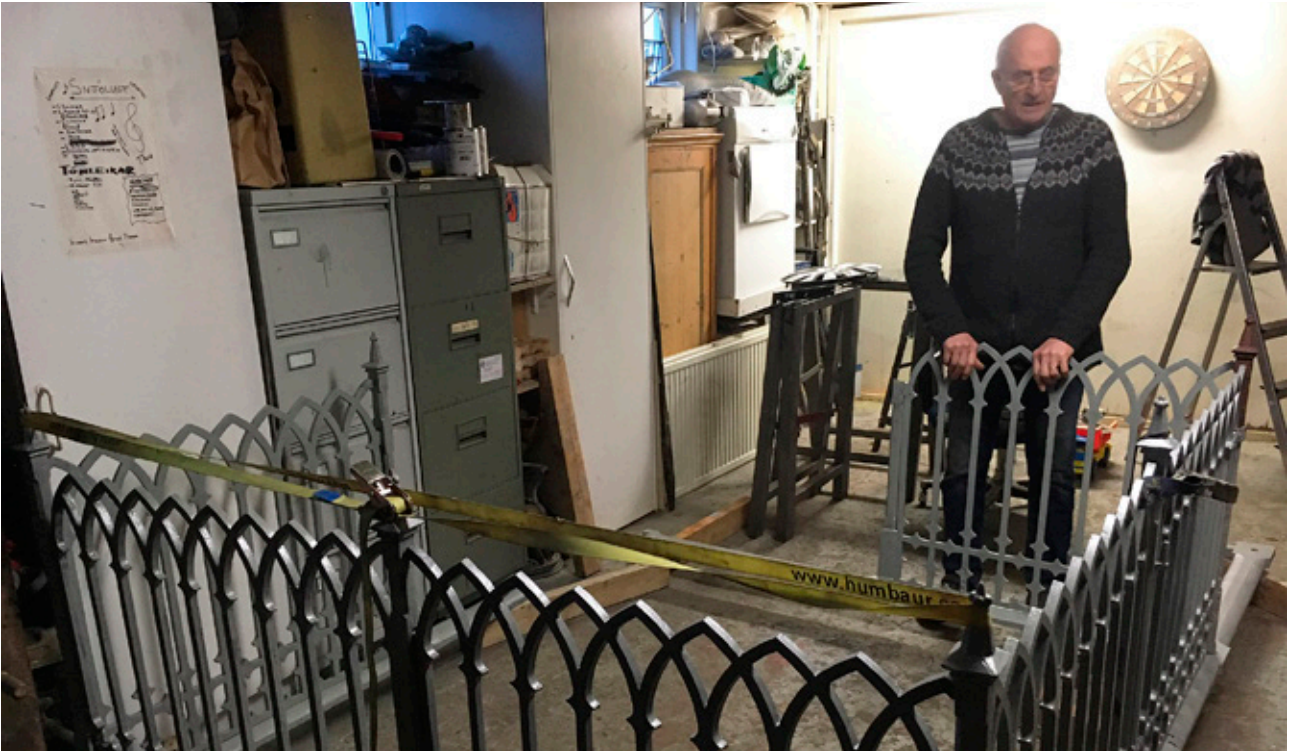
Karl Þórir í bílskúrnum sínum. Búinn að taka sundur grindurnar, sandblása og grunna. Bæta þurfti grindur og steypa nýja hornstólpa úr pottjárni.
