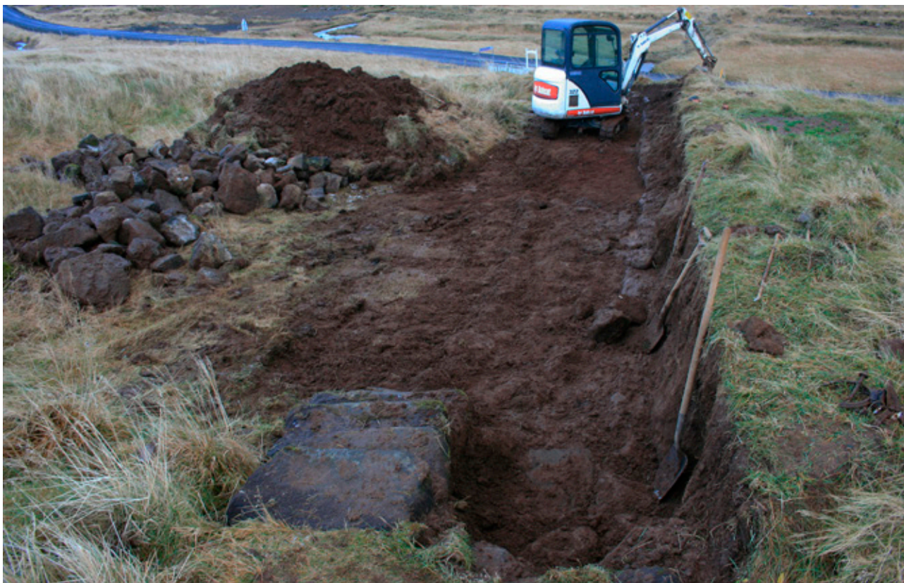
Endurgerð kirkjugarðsveggja að hefjast haustið 2015. Búið að taka norðurvegginn niður. Glittir í undirstöðuna.
