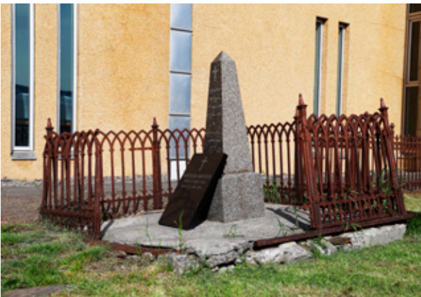
Leiði Hafsteinsbarna fyrir viðgerðir. Pottjárnsumgjörð brotin og steipt undirstaða farin var að skekkjast og springa. Myndin er tekin 1. júlí 2021.
