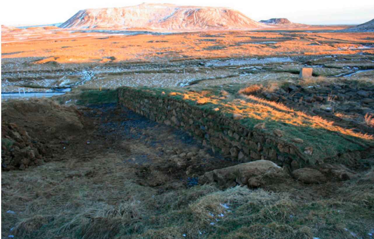
Hleðslu norðurveggjar lokið. Til hægri má sjá grunn kirkjunnar sem brann 2010. Austan hans má sjá minningarmark Árna sýslumanns Gíslasonar.
