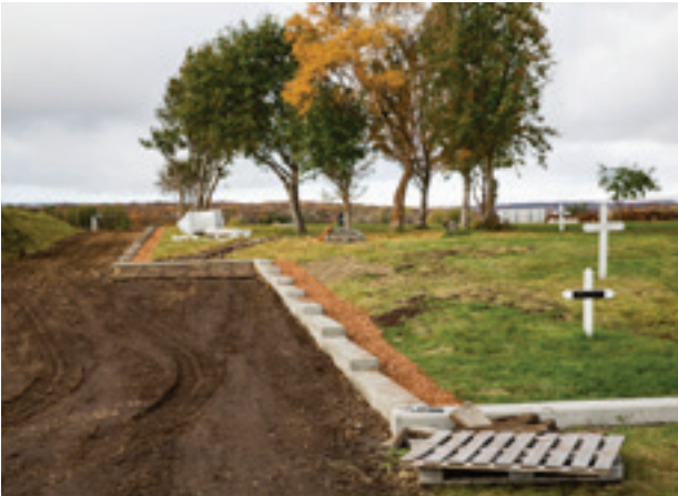
Hér má sjá undirstöður grindverksins að sunnanverðu.
