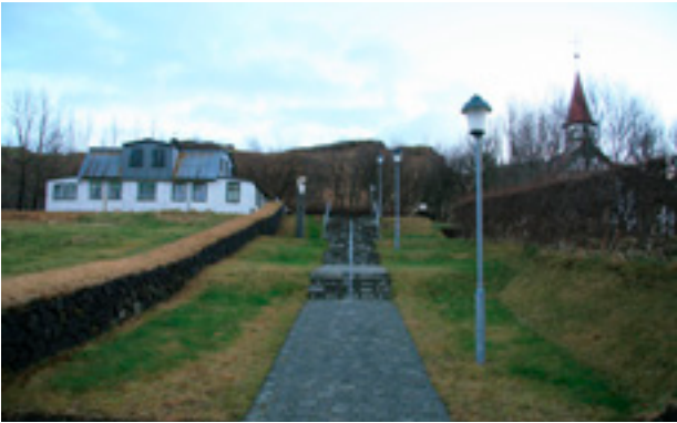
Tröppur upp að kirkju austan Gamla prestsetursins voru endurnýjaðar og lýsing bætt.
