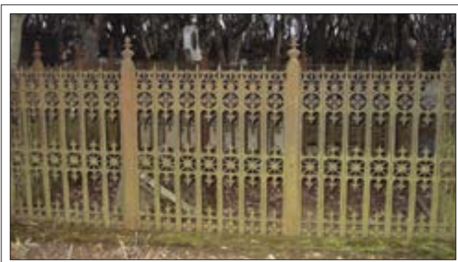
Steypujárngirðing fyrir og eftir viðgerð.
