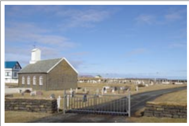
Hér sést yfir garðinn. Nýja hliðið í forgrunni, þjónustuhúsið falið undir brekkunni í fjarska.
