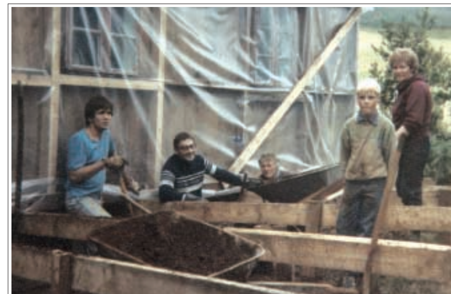
Framkvæmdir hafnar, verið að grafa frá kirkjunni og búið að rífa klæðninguna af.
